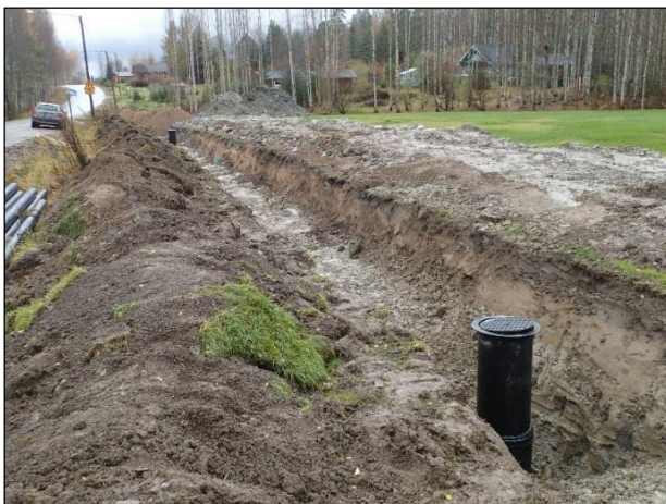
Juuri kaivettua vesihuoltolinjan kaivantoa Maisematie 539 kohdalla. Luoteeseen.
