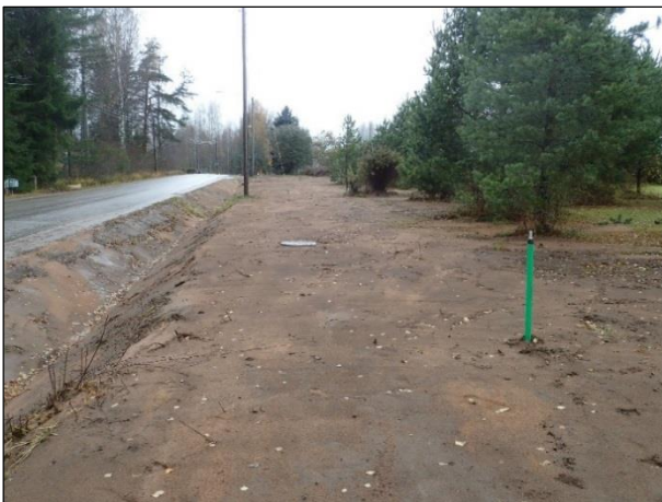
Linjan kulkua Maisematie 555 alueella. Samalla paikalla juuri perattua maantieojaa sekä kaivettua ja peitettyä vesihuoltolinjaa. Luoteeseen (vas). Juuri kaivettua vesihuoltolinjan kaivantoa Maisematie 535 alueella. Luoteeseen (oik.).
