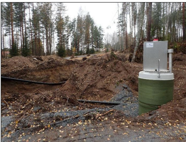
Tuore vesihuoltolinjan kaivanto Maisematie 715 kohdalla. Luoteeseen.
