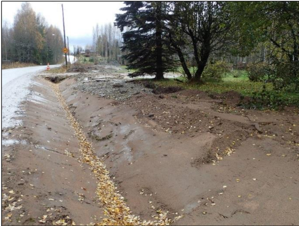
Linjan kulkua Maisematie 547 alueella. Samalla paikalla juuri perattua maantieojaa, kaivettua ja peitettyä vesihuoltolinjaa sekä hoidettua pihamaata. Luoteeseen.
